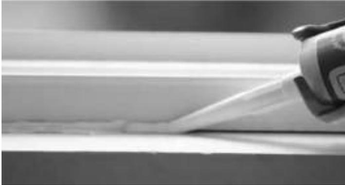
Ya aplicado el silicón sobre todo el contorno tanto interior como exterior se deben retirar excesos e impurezas.
